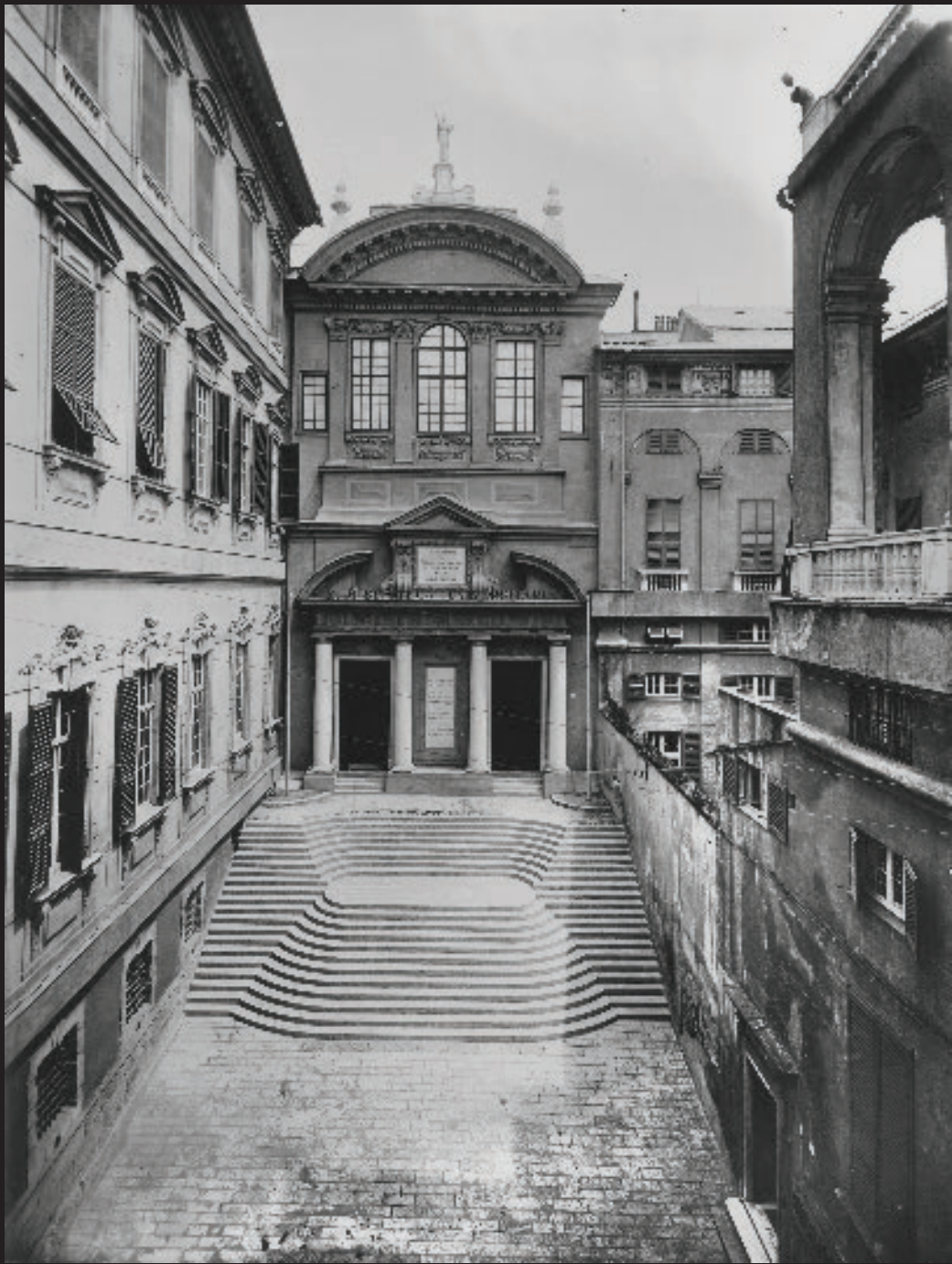
Facciata e scalinata d'accesso alla sede storica della Biblioteca, anni '30 del Novecento, BUG, Fondo Fotografico
